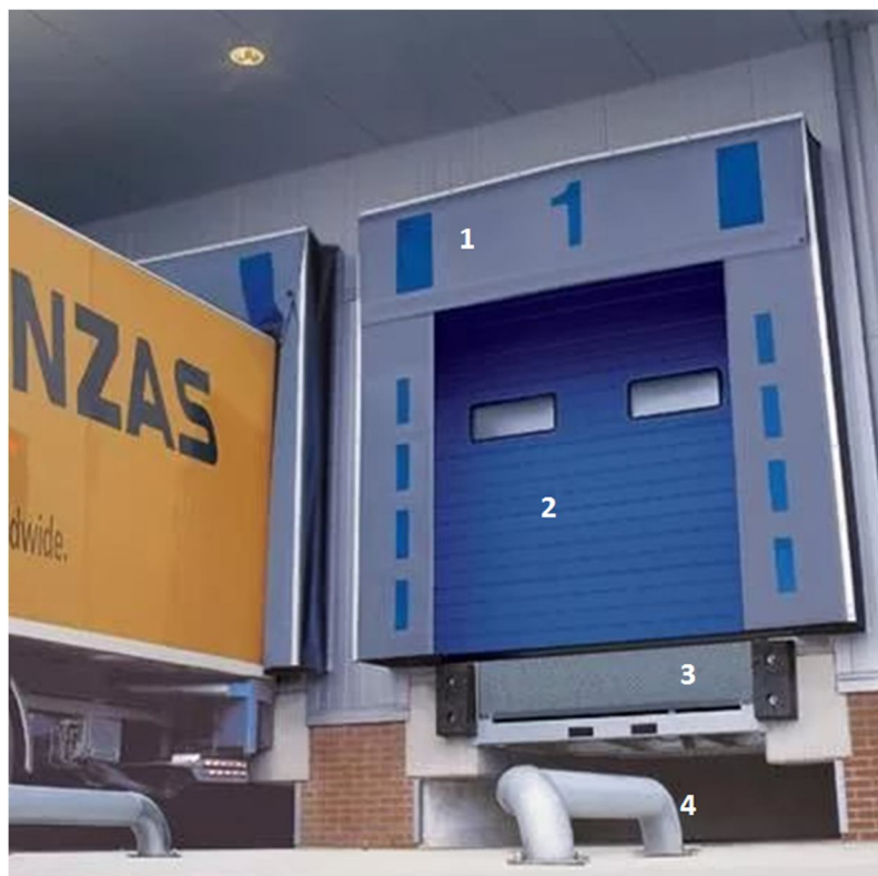
Рис. 2.16. Оборудование погрузочной зоны терминала: 1 - герметизатор; 2 - секционные ворота; 3 - доквеллер с откидной аппарелью; 4 - отбойники-направляющие для колес подвижного состава
