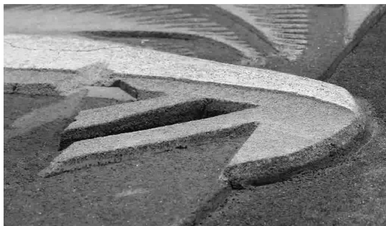
Рис. 5.2. Расположение слоев в разноуровневом рельефе сграффито
