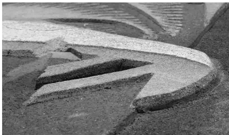
Рис. 5.2. Расположение слоев в разноуровневом рельефе сграффито
