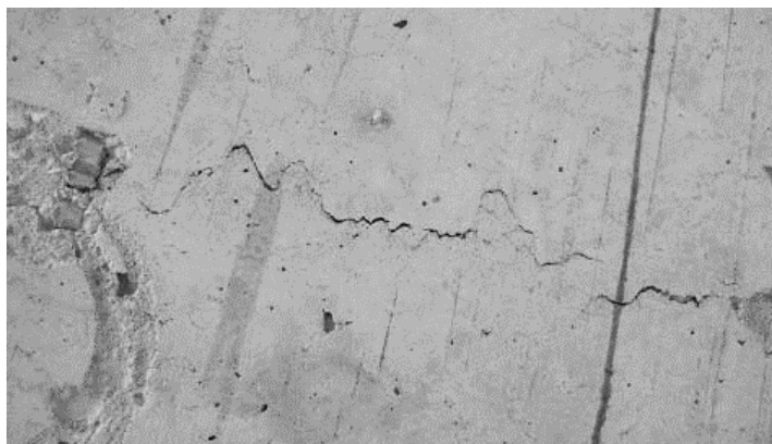
Рис. 7.2. Усадочные трещины
