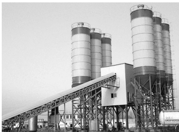
Рис. 4.2. Общий вид завода с двухступенчатой схемой приготовления бетонных смесей
