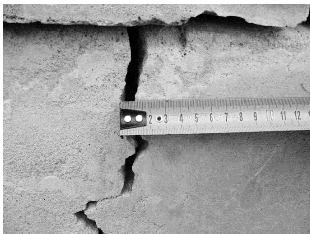
Рис. 7.6. Неустранимый брак готового железобетонного изделия
