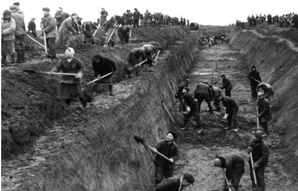
На строительстве оборонительной линии
