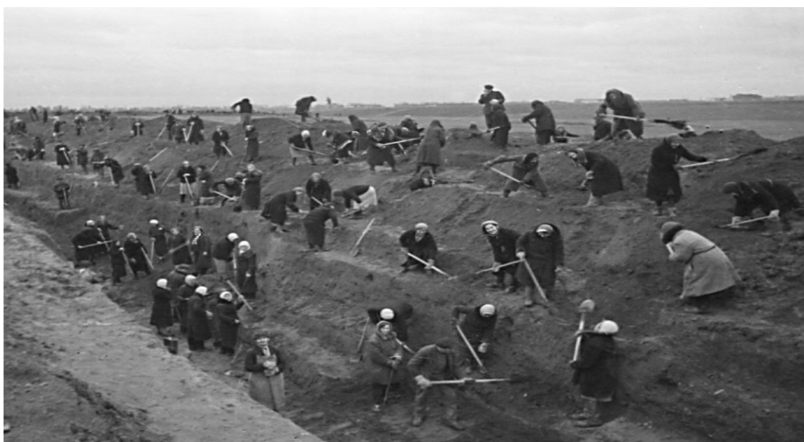
Жители Иванова на строительстве оборонительных сооружений
